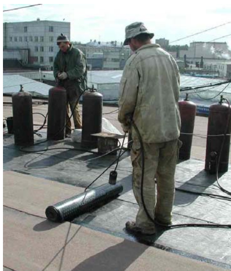
Рис. 14. Положение рабочего при укладке.
