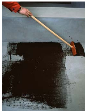
Рис. 10. Нанесение грунтовки.
