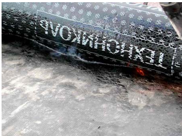
Рис. 15. Валик расплавленного битумного вяжущего.
